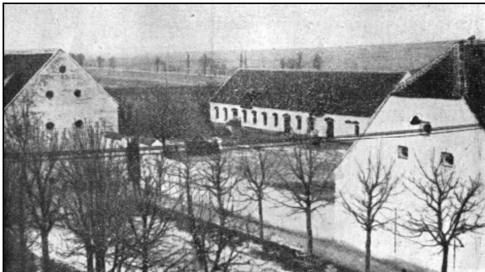
Panský dvůr Na valech (pustém hradě) se strany jihovýchodní na podzim r. 1926 před zbořením.
